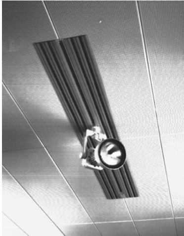
Exemple d'un montage d'une lampe avec LDB 12/-/1/20
