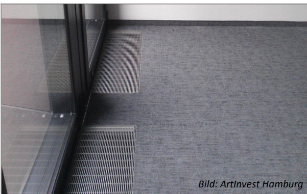
Exemple d'installation type VKB-N
